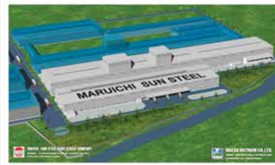
NHÀ MÁY MARUICHI SUN STEEL - BÌNH DƯƠNG
