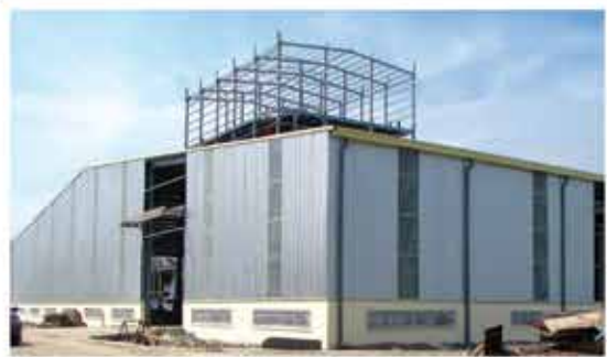
CÔNG TRÌNH AN CƯ - KCN LONG AN
