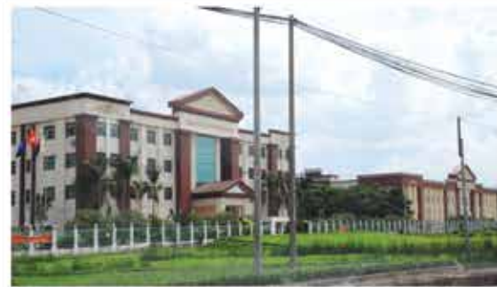
NHÀ MÁY SHING MARK - ĐỒNG NAI
