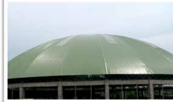
NHÀ MÁY XI MĂNG - BÌNH PHƯỚC
