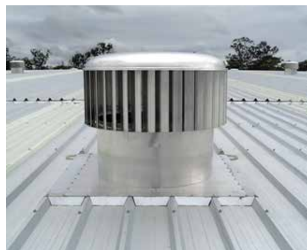
Thông gió Roof ventilator
