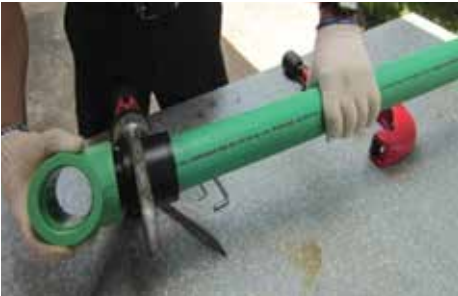
Gia nhiệt đầu ống và khớp nối cần dán Heating the jointing surfaces of pipe and socket.
