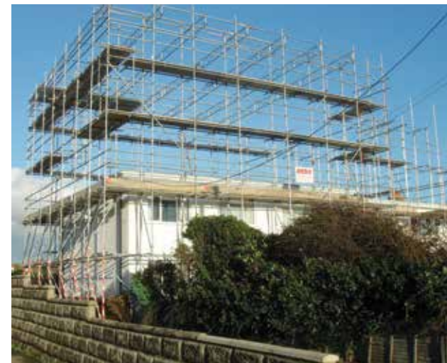
Ứng dụng khác trong xây dựng (Dàn giáo, Copphe, ...) Being used in building such as constructive scaffold, shuttering
