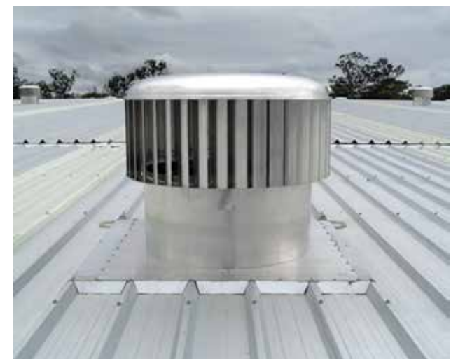
Thông gió Roof ventilator
