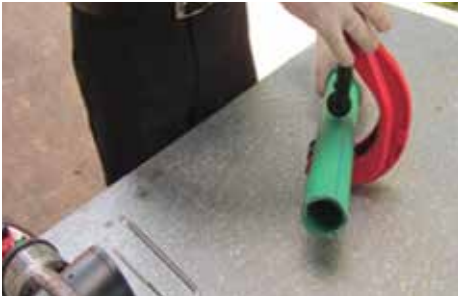
Cắt phẳng và lau sạch các mặt đầu ống cần nối. Trimming and cleaning the inner and outer surface of pipe and socket.
