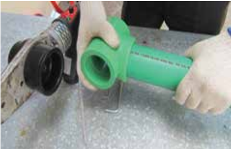
Ép chặt đầu ống vào khớp nối cần dán và giữ cho đến khi mối nối vững chắc Pressing the pipe and socket surfaces together and holding in place until an attached joint is firm.
